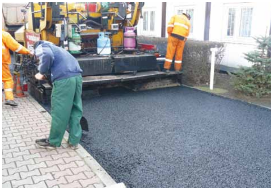
6. Wbudowywanie mieszanki na bazie asfaltu modyfikowanego gumą
