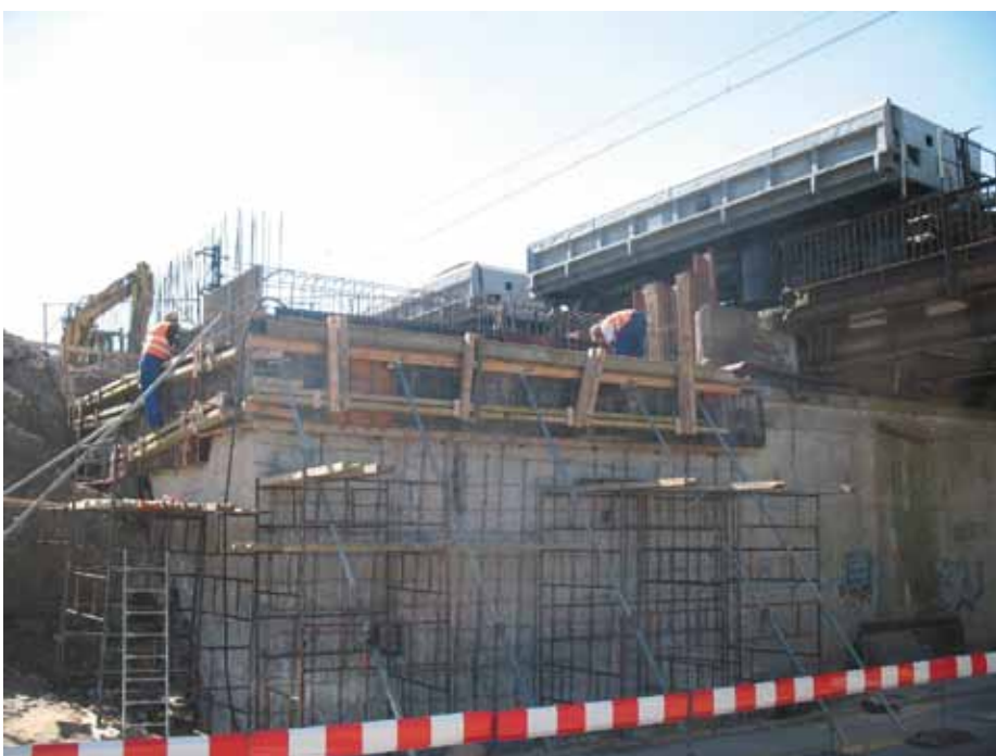
13. Wiadukt kolejowy w km 26+323 nad ul. Piłsudskiego w Obornikach Śl. Remont i nadbudowa podpór. Modernizacja i wzmocnienie istniejących przęseł blachownicowych.
