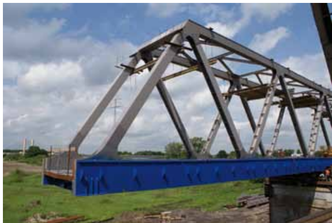
12. Most kolejowy w km 5+845 nad rzeką Odra. Nasuwanie nowego przęsła nurtowego.
