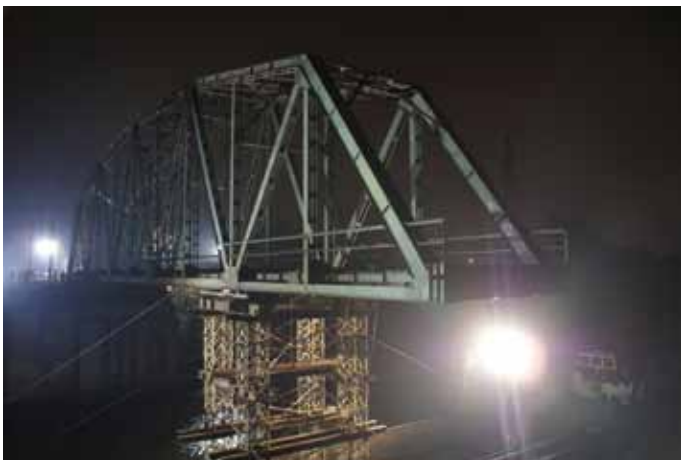
11. Most kolejowy w km 5+845 nad rzeką Odra. Demontaż przęsła nurtowego.
