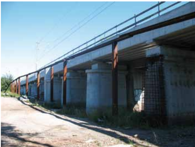
3. Most kolejowy w km 14+671 nad rzeką Widawa. Przebudowa i naprawa podpór, wymiana przęseł na nowe, płytki z dźwigarów obetonowanych
