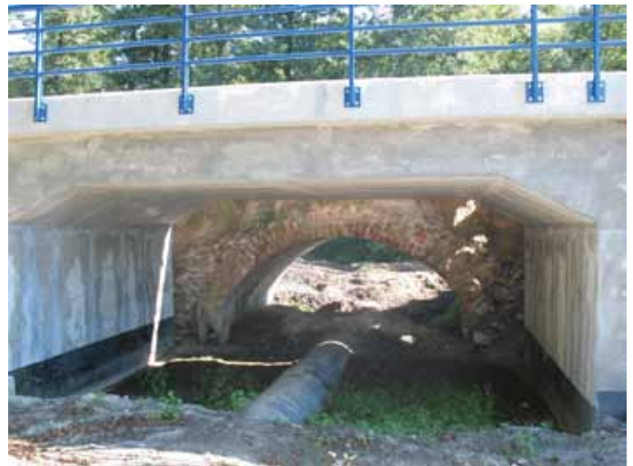
4. Przebudowa mostu kolejowego w km 17+727 nad rzeką Mienia. Likwidacja istniejącego, budowa nowego obiektu żelbetowego, ramowego.
