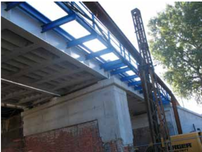
1. Wiadukt kolejowy w km 2+504. Nadbudowa ławy podłożyskowej, wymiana przęseł na nowe
