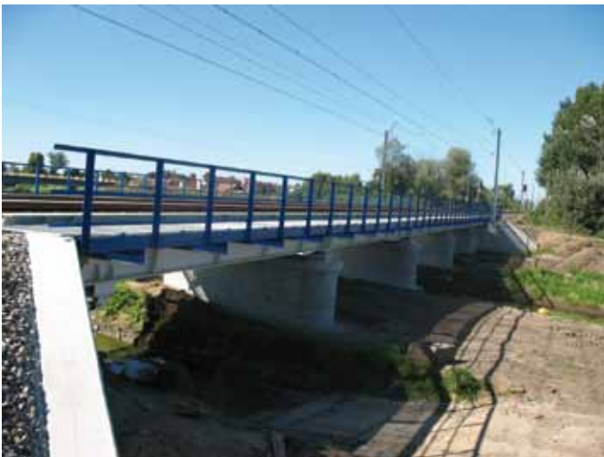
7. Most kolejowy w km 54+810 nad rzeką Orla. Remont podpór, wymiana przęseł na nowe, stalowe, ciągłe, blachownicowe.
