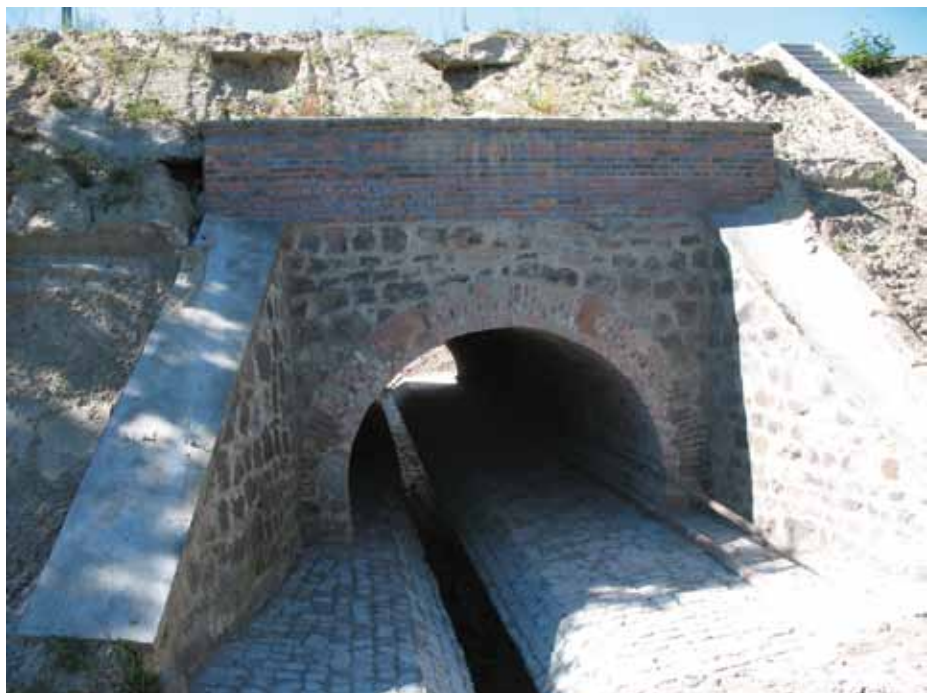
15. Most kolejowy w km 30+990 nad rzeką Krępa. Remont obiektu istniejącego.
