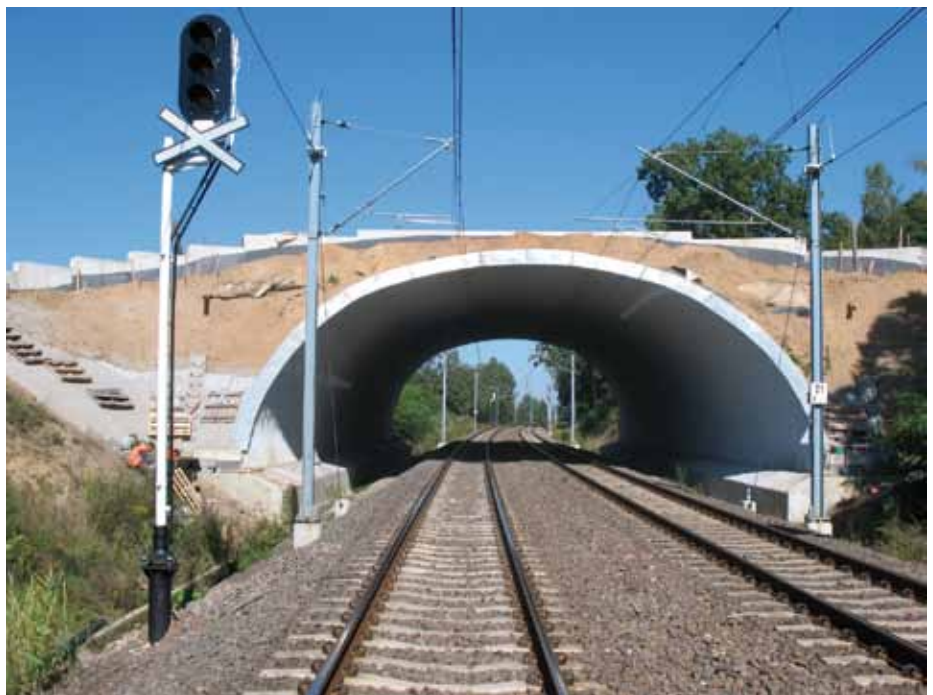
14. Ekodukt w km 21+012. Budowa nowego obiektu ekologicznego.
