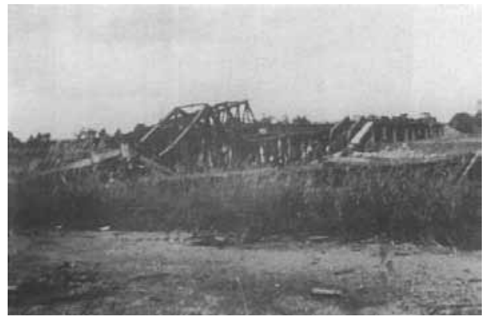
5. Widok mostu zniszczonego podczas walk o Festung Breslau. [5]
