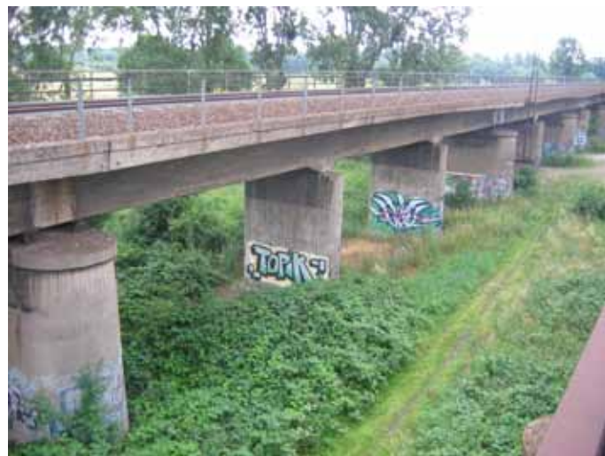
8. Ciągła, trójprzęsłowa konstrukcja w torze nr 1 na przełomie XX/XXI w. Widoczne filary wahaczowe. [5]
