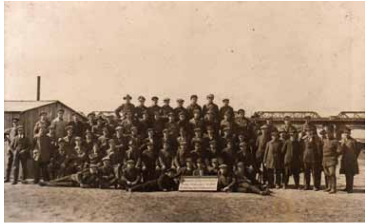
3. Zdjęcie pamiątkowe na tle mostu z pierwszej połowy XX w. Wrocławska firma budowlana prowadziła prace na terenie zalewowym. [5]
