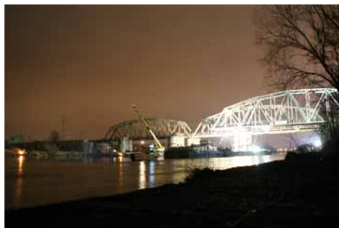
10. Demontaż przęsła kratownicowego z użyciem podpory pływającej [7]
