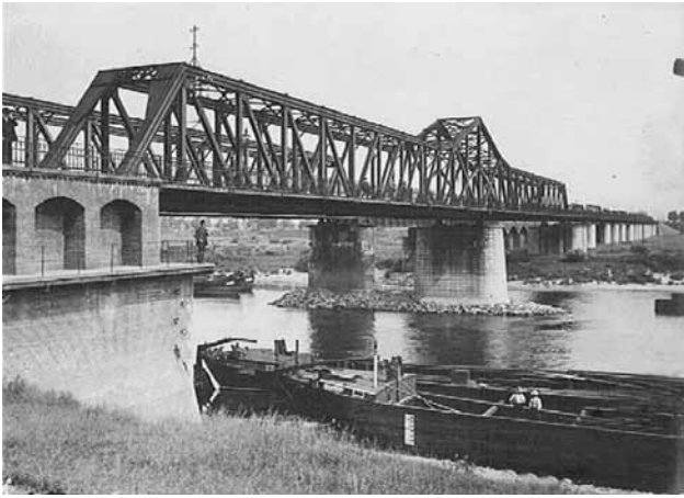
2. Most na początku XX w. Na pierwszym planie ciągła, dwuprzęsłowa kratownica nurtowa w torze nr 1. [3]
