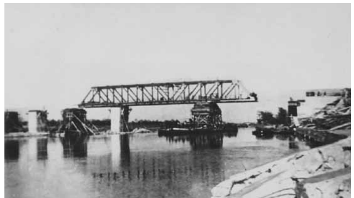
6b. Kolejne fazy nasuwania kratownicy podczas odbudowy mostu. [1], [2]
