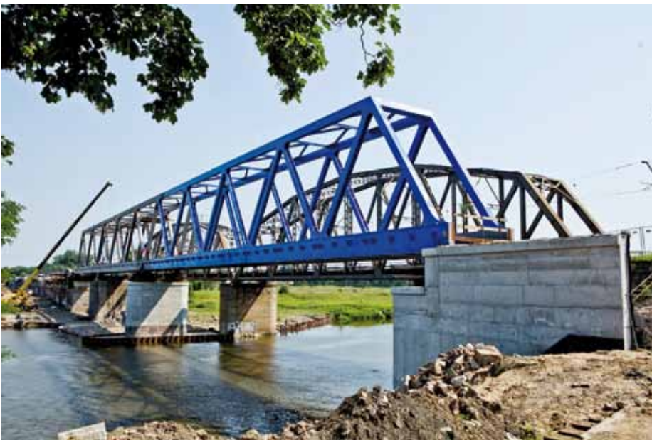
11. Konstrukcja nośna jeszcze przed opuszczeniem na łożyska. [8]
