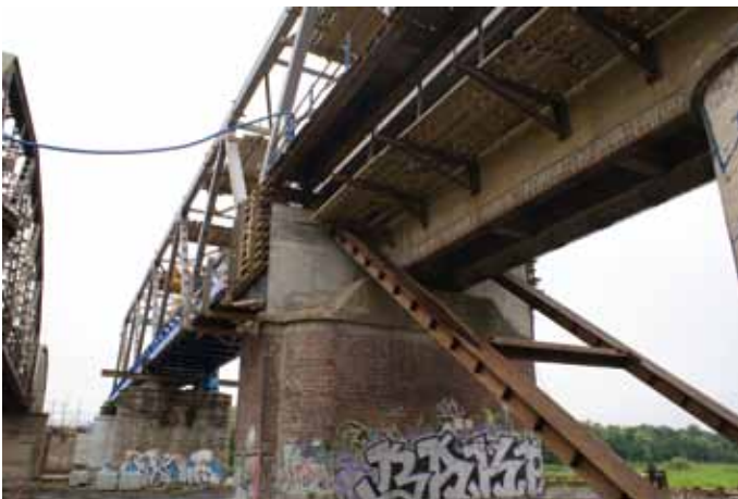
10. Podpora F3 – zabezpieczenie stateczności
