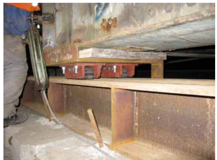
4. Łożysko toczne na torze wysuwowym (grudzień 2012 r.)
