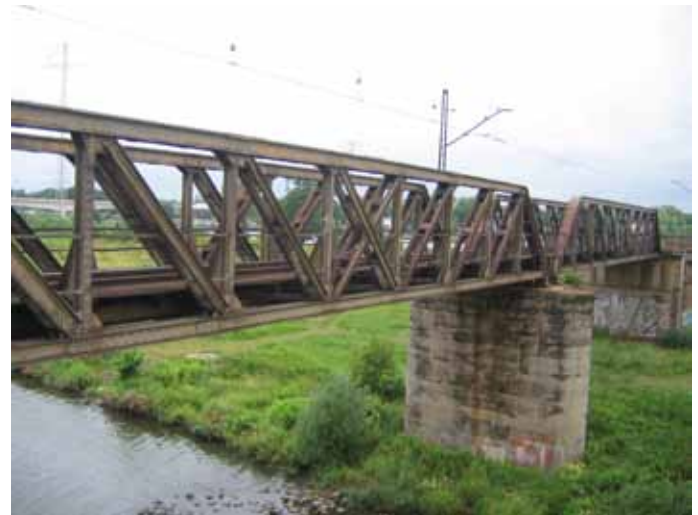
2. Stalowe przęsła kratowe o rozpiętości 32,67 m
