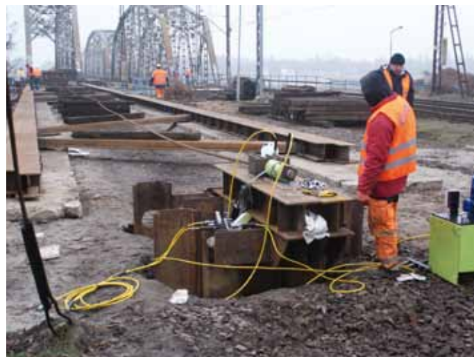
6. Widok na stanowisko oporowe siłownika hydraulicznego
