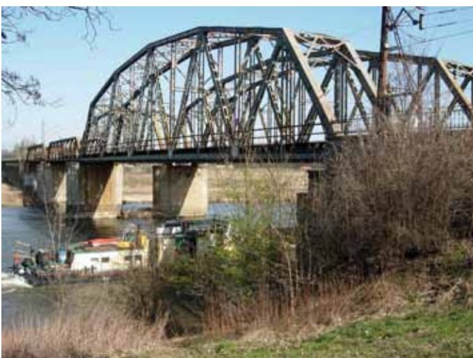
3. Stalowe przęsła kratowe o rozpiętości 61,80 m
