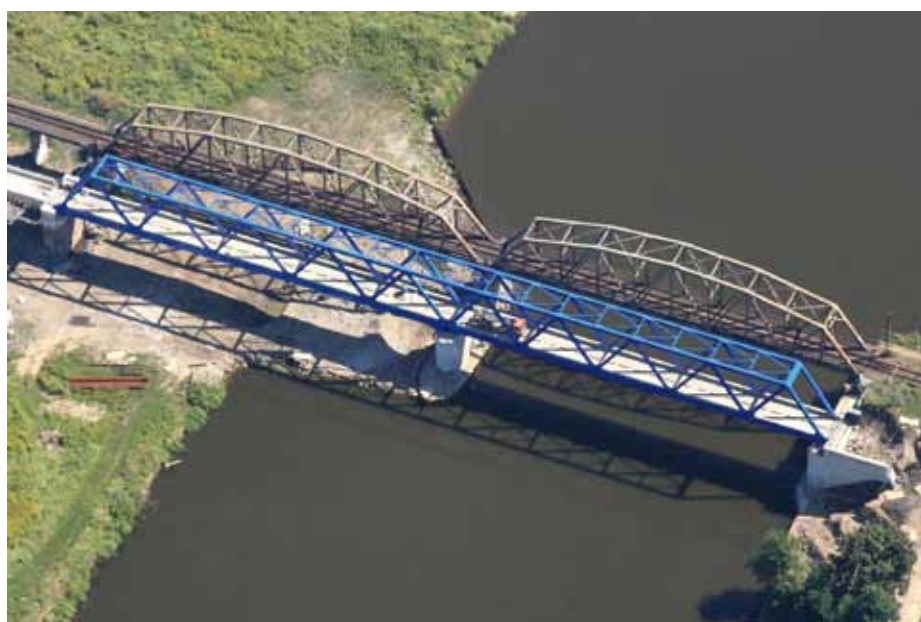
13. Widok z lotu ptaka nowej konstrukcji, po jej nasuwie w położenie docelowe
