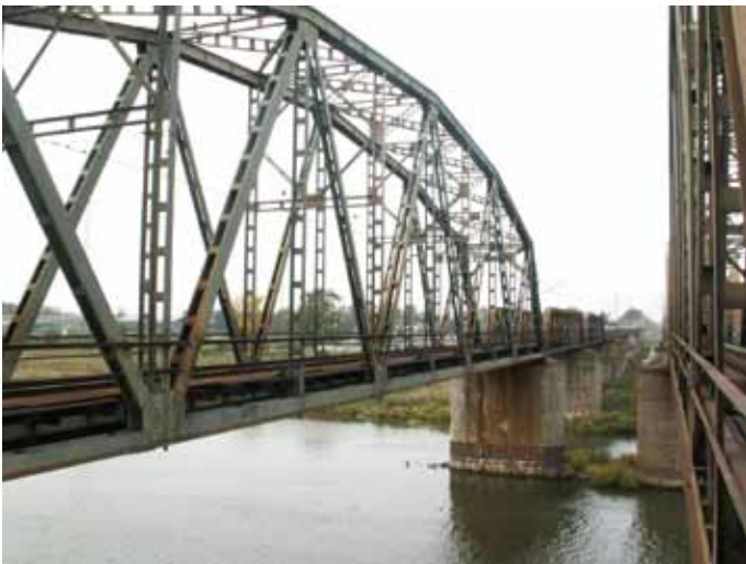
1. Stan mostu kolejowego przed przystąpieniem do robót (2004 r.)
