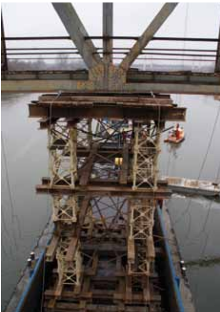
8. Widok na podporę pływającą
