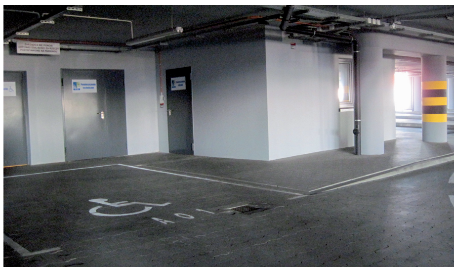
4. Miejsce postojowe wyznaczone na tyłach pomieszczenia ochrony parkingu sprzyja udzieleniu pomocy przez obsługę.
