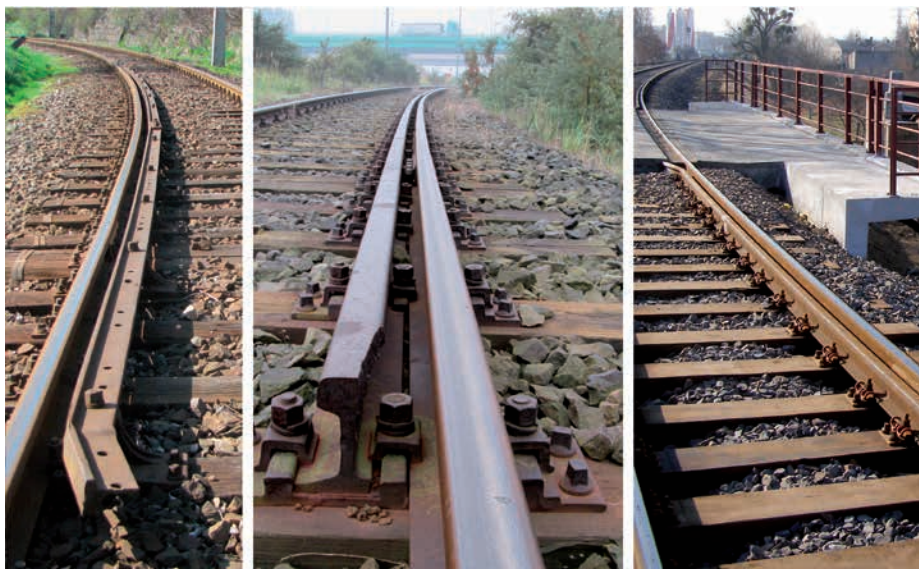
7. Różne sposoby wykonania w torze prowadnicy – na zdjęciu z lewej strony mocowanie prowadnicy ułożonej „na płask” do gajcówek na linii 311, w środku i z prawej rozwiązania części spotykane: prowadnica z szyny starożytecznej, mocowana do podkładki żebrowej
