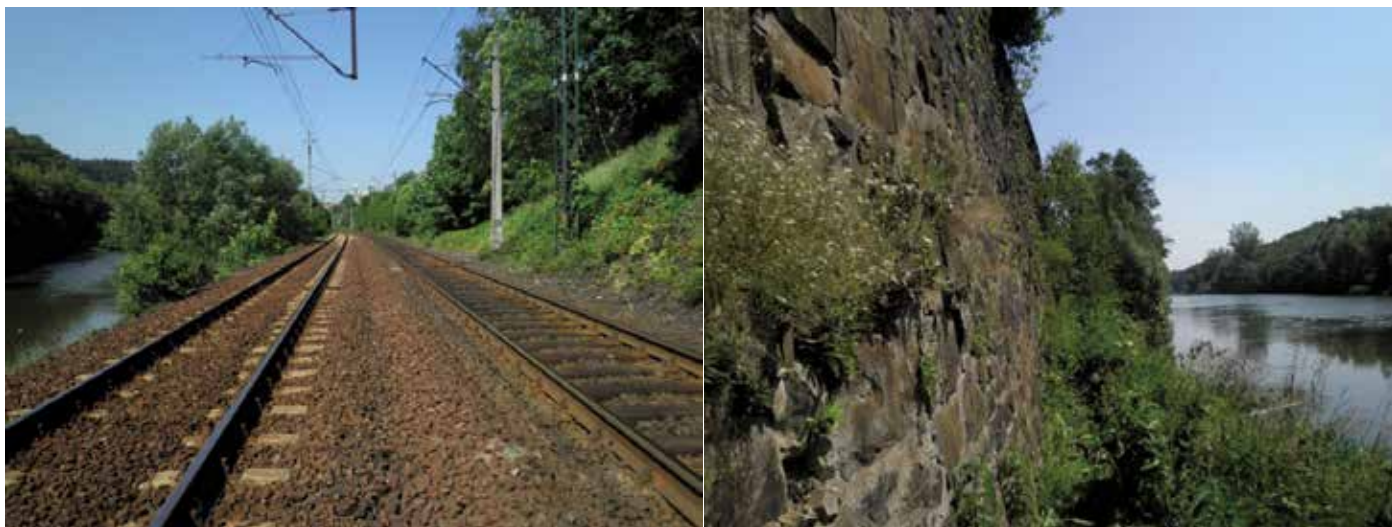
3. Mur oporowy w linii nr 276 Wrocław-Międzyzlesie: a) Widok od strony torowiska, b) Strona odpowietrzana kamiennego muru oporowego [14]
