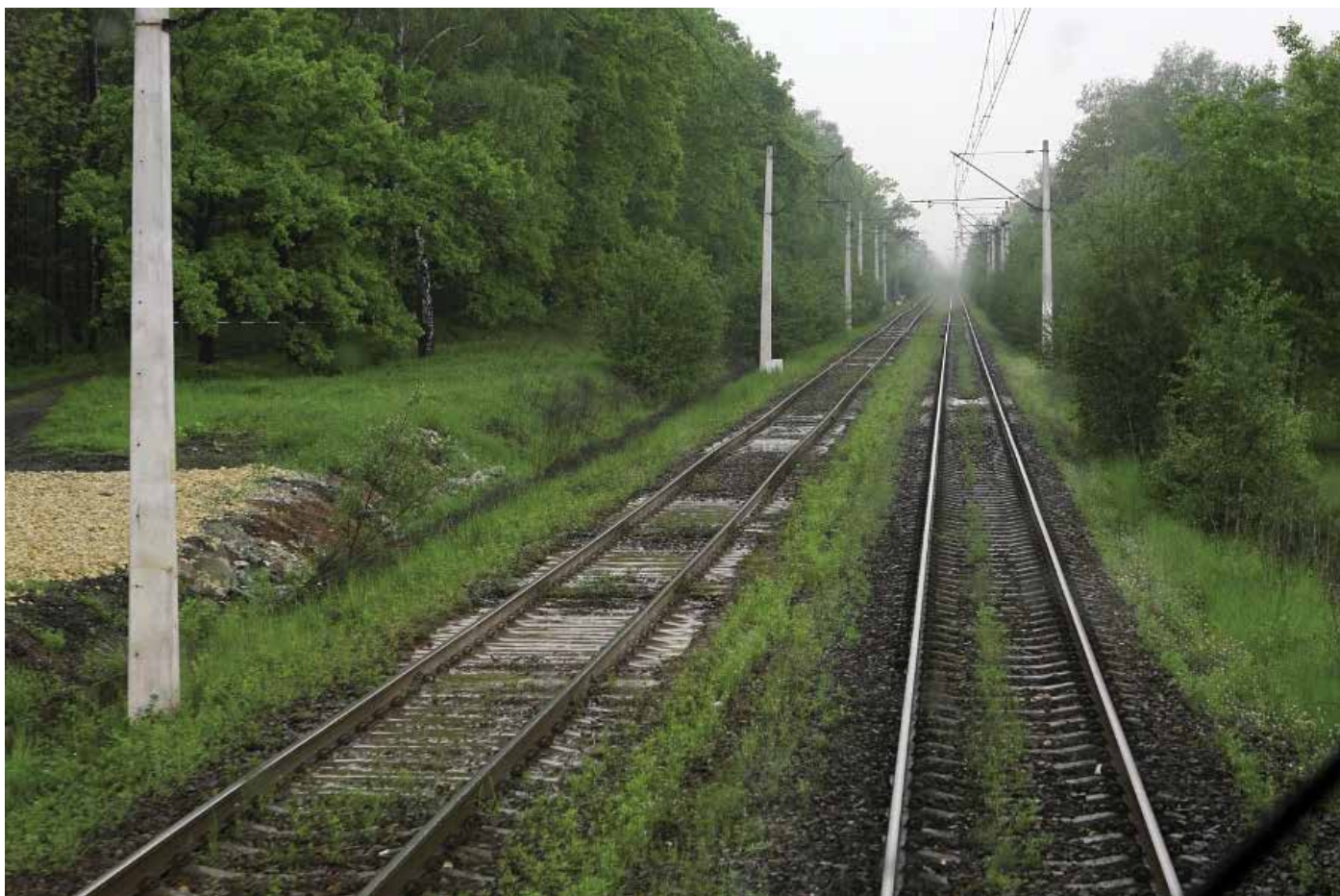
1. Przykład zastoiska wody na odkształconym torowisku („wylapły”).
