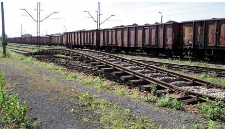
7. Przykład wyboczenia toru odstawczego boczniczy kopalnianej
