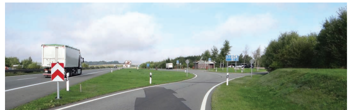
11. Pas rozdzielający autostradę od terenu parkingowego obsiany jedynie trawą
