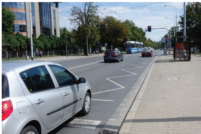
1. Przystanek bez wydzielonych wysepek „Hutmen” – ul. Grabiszyńska we Wrocławiu (fot. Cz. Wolek)
