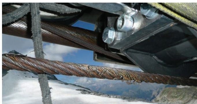
10. Pęknięcia drutów wskutek działania korozji zmęczeniowej [7]
