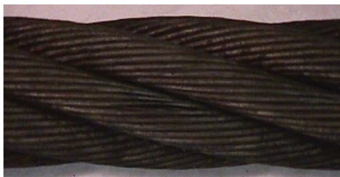
9. Zmiany geometrii drutów liny 76 mm zużytych na skutek korozji frettingowej
