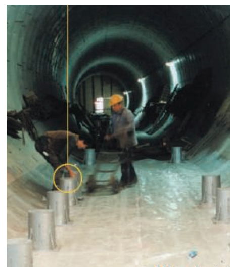
6. Kalibracja napięcia sprężyny w tłumiku typu GSI
