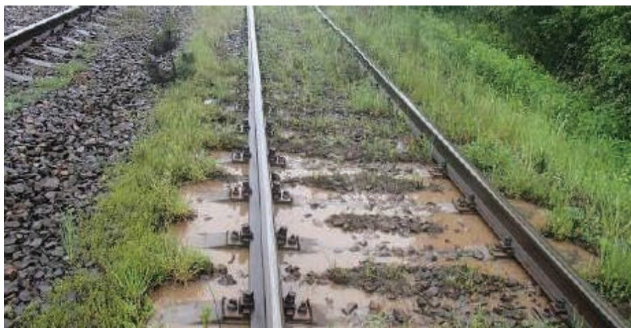
13. Wychłapki w torze kolejowym [21]
