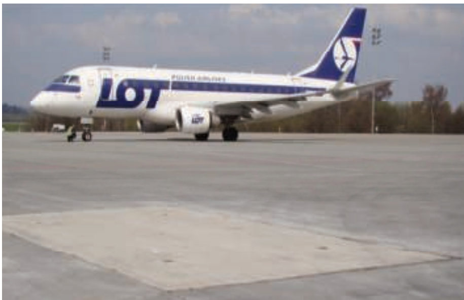
4. Płyta prefabrykowana na nawierzchni lotniskowej PPS na lotnisku Kraków-Balice
