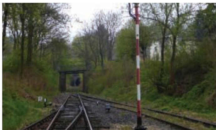
17. Most drogowy i tunel widoczny ze stacji Wleń
