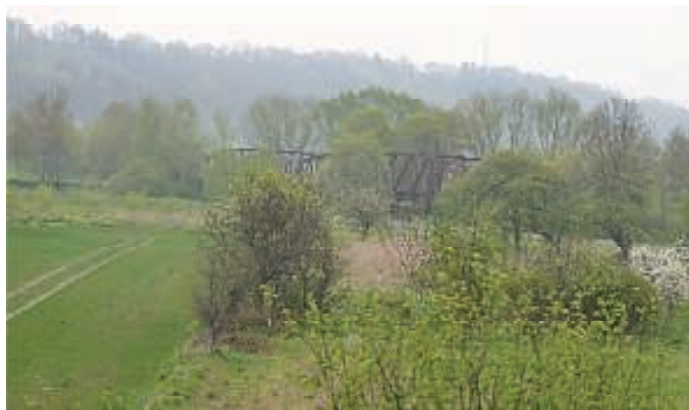
12. Most kolejowy do Jerzmanic Zdroju nad rzeką Bóbr
