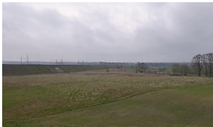
5. Widok nasypu i wiaduktu nad rzeką Kwisą linii kolejowej E30 z linii 283 w pobliżu Zebrzydowej
