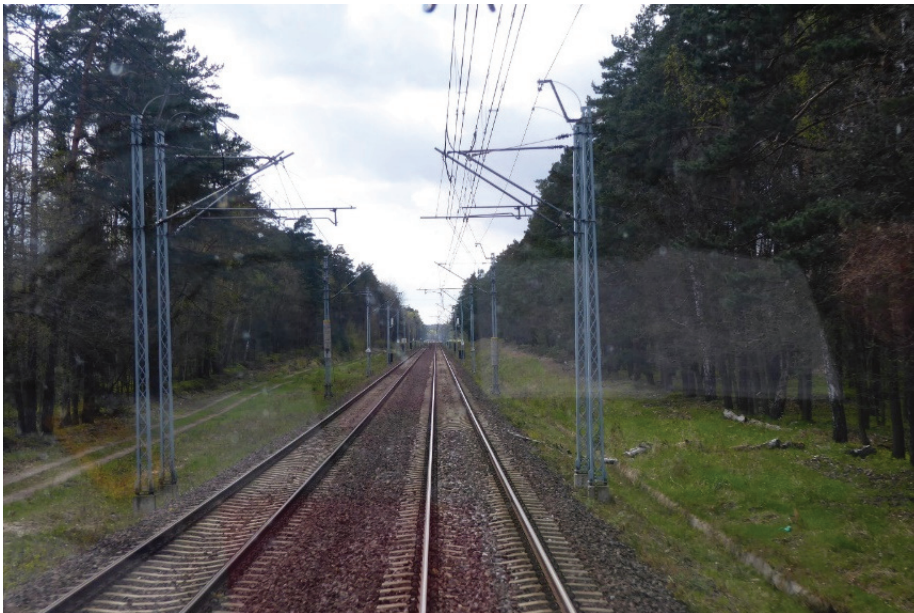
1. Widok z kabiny szynobusu w miejscu starego odejścia bocznicy kolejowej do Zielonki po lewej stronie
