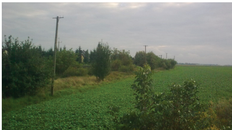
5. Tor linii kolejowej nr 310 Kobierzycy -Bielawa Górna widziany na wyjeździe z Kobierzyc do Sobótki na linii nr 285
