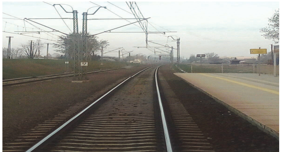
3. Konstrukcje wsporcze zasilające widok maszyniście na szlaku
