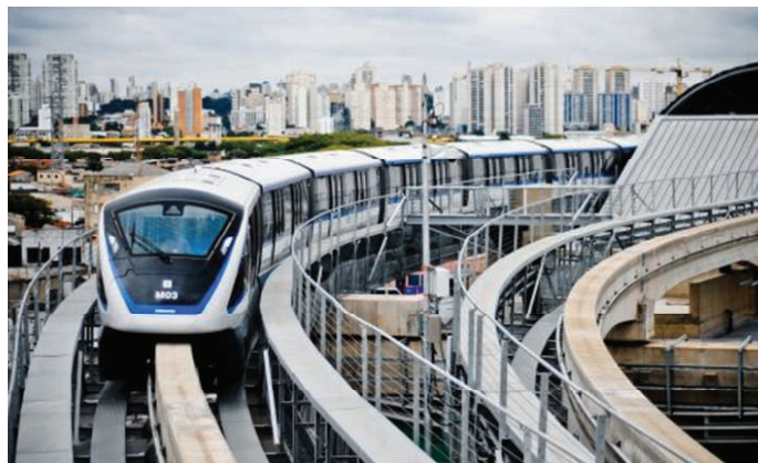
14. Chodnik ewakuacyjny wzdłuż linii kolei jednoszynowej w Saõ Paulo (Brazylia). Źródło: strona internetowa [25]
