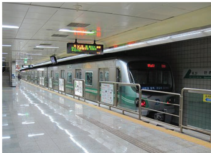
16. Pół-drzwi peronowe na stacji kolei jednoszynowej w Daegu (Korea Płd.) Źródło: strona internetowa [65]
