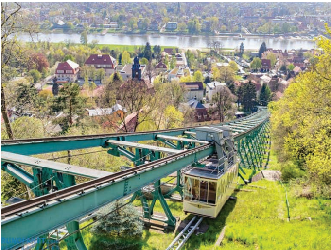
7. Drezdeńska (Niemcy) jednoszynowa kolej linowa Źródło: strona internetowa [23]
