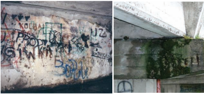
14. Zanieczyszczenia nieorganiczne neutralne (po lewej) oraz powierzchniowe zanieczyszczenia organiczne w postaci glonów (po prawej)
