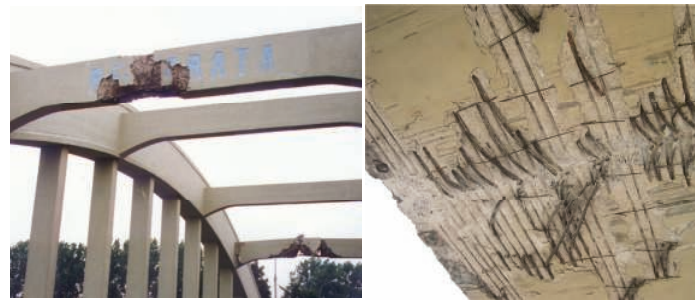
9. Deformacje oraz ubytki i utrata ciągliwości materiału elementów żelbetonowej konstrukcji mostowej na skutek przeciążeń wywołanych uderzeniami pojazdów o ponadnormatywnych wymiarach
