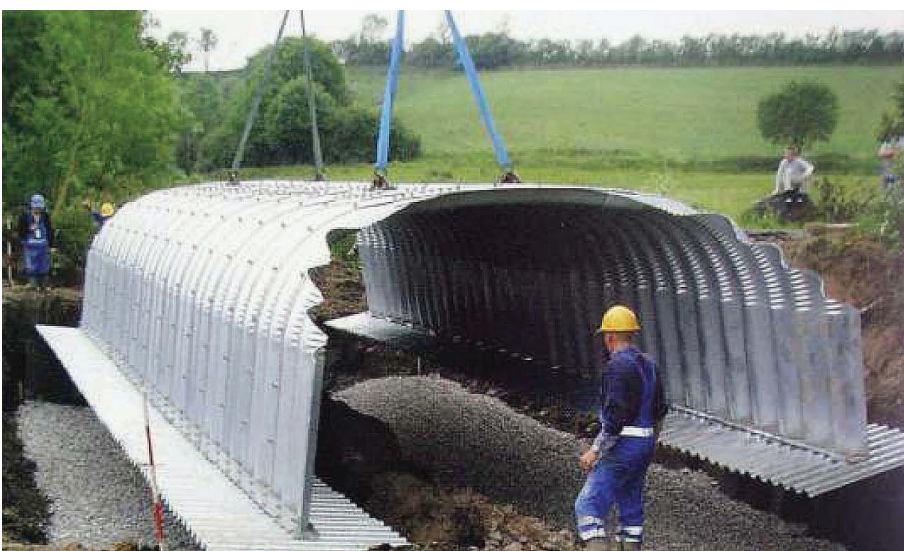
3. Konstrukcja powłoki z podparciem na blasze falistej [5]
