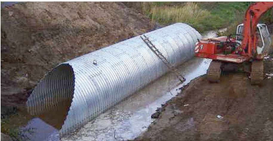
1. Realizacja budowy obiektu w cieku wodnym
