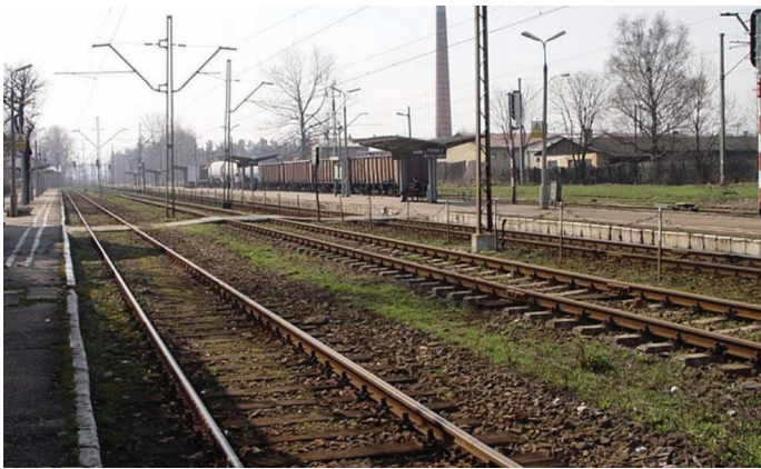
29. Stacja Nowy Targ widok w kierunku Zakopanego
