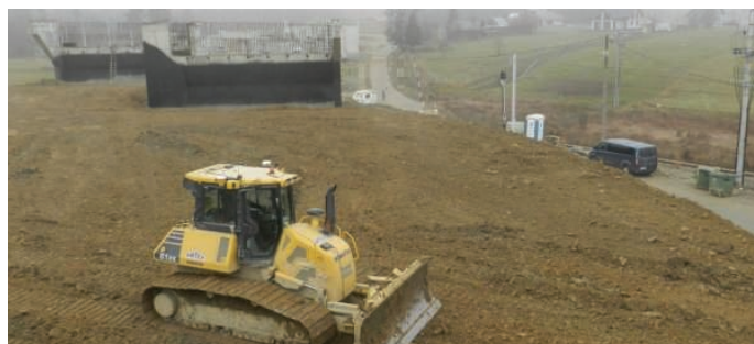
28. Obwodnica Nowego Targu w ciągu DK 47 z prawej linia nr 99 w rejonie planowanego posterunku odgałęźnego Grel
