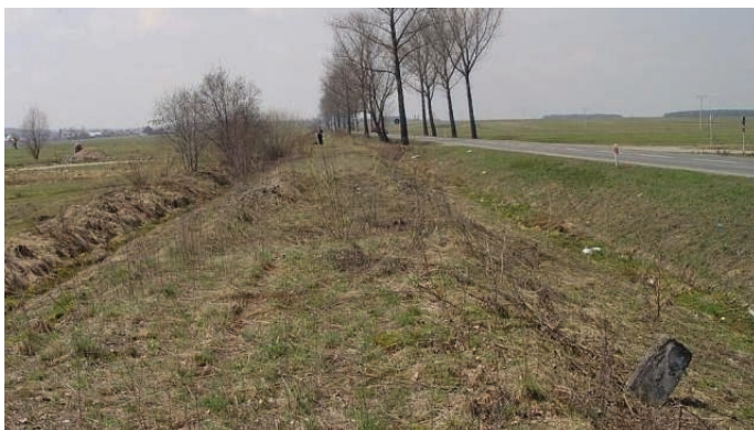
33. Pas kolejowy dawnej linii nr 118 w rejonie Ludźmierza; widok w kierunku Rogoźnika.
