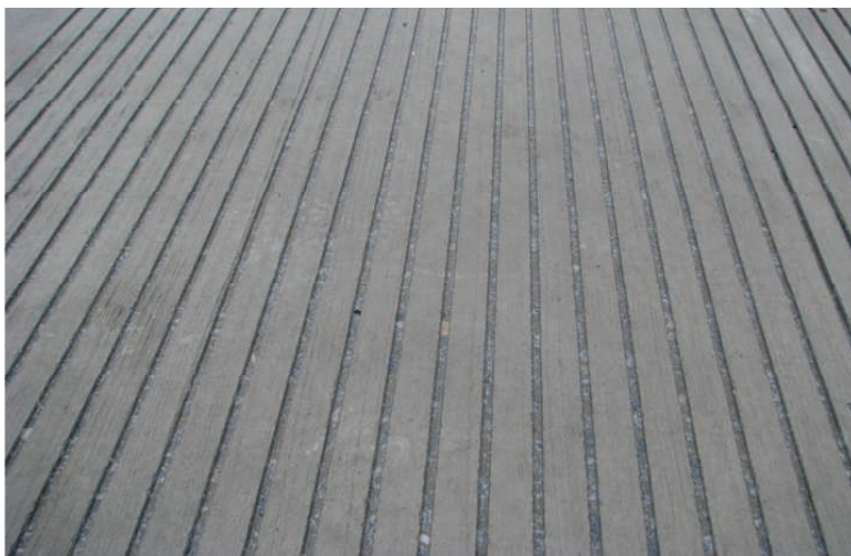
9. Tekstura nawierzchni w wyniku jej rowkowania
