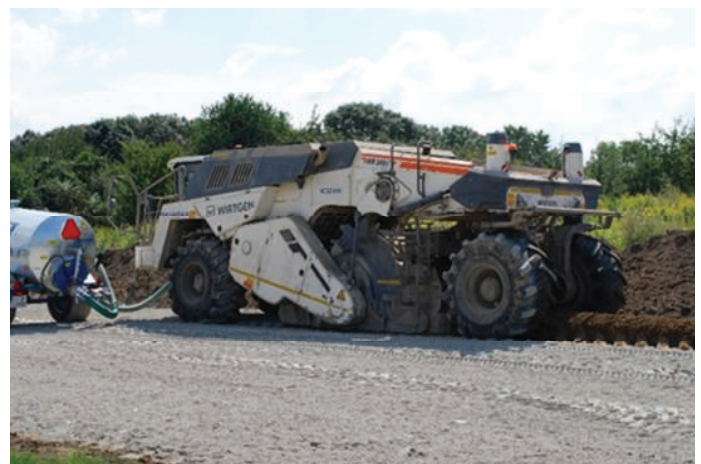
5. Proces mieszania gruntu rodzimego ze środkiem chemicznym
