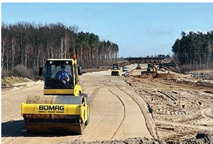
4. Zagęszczanie mechaniczne podłoża gruntowego
