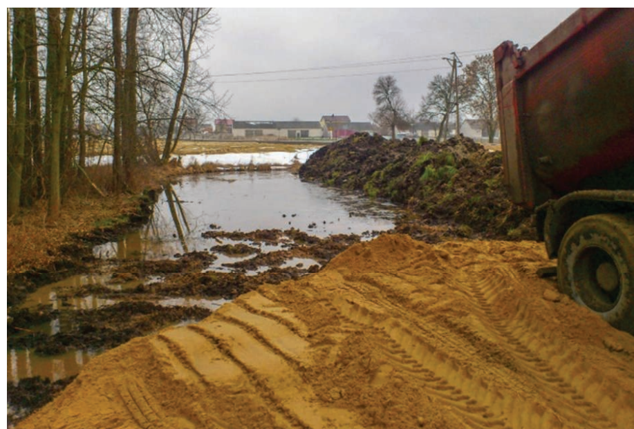
7. Wymiana gruntów słabonośnych
