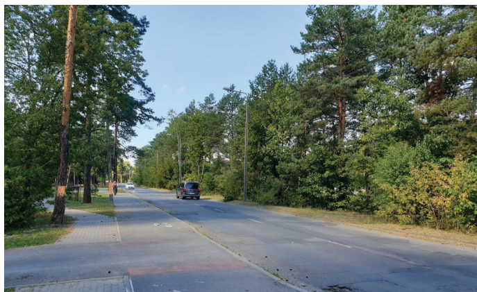
2. Miejsce odejścia od linii kolejowej nr 7 i przecięcia ul. Armii Krajowej w Otwocku, widok w kierunku stacji Otwock.
