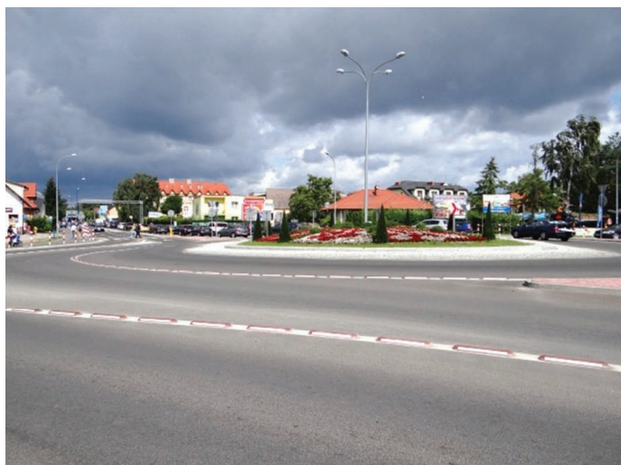
1. Przykład ronda w Dziwnówku – typu „Partiële turborotonde” z trzema pasami ruchu na zachodniej części jezdni ronda (Fot. A. Sołowczuk)
