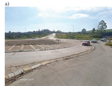
4. Pierwsze rondo częściowo turbinowe wybudowane na przedmieściach Khandisa w Zuzuland w RPA na skrzyżowaniu dróg R102/P535/P743: a) pas separacyjny z wyniesionym krawężnikiem, b) część przejezdna (Źródło: Google Earth [18] – współrzędne geograficzne 28°51'50.32"S, 31°51'15.75"E)
