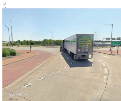
3. Rondo typu „look-a-like” na skrzyżowaniu drogi stanowej 41 z ulicami Breezewood Ln oraz W Bell St Neenah w USA: a) plan czterech rond; b) mulda i dostosowane wpusty deszczowe do jej obłego kształtu; c) widok na krawężnik oddzielający przejezdną część ronda od jezdni ronda (Źródło: Google Earth [18] – współrzędne geograficzne 44°9'22.55"N, 88°29'8.49"W)
