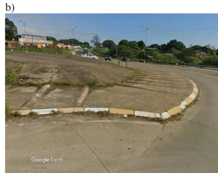
4. Pierwsze rondo częściowo turbinowe wybudowane na przedmieściach Khandisa w Zuzuland w RPA na skrzyżowaniu dróg R102/P535/P743: a) pas separacyjny z wyniesionym krawężnikiem, b) część przejezdna (Źródło: Google Earth [18] – współrzędne geograficzne 28°51'50.32"S, 31°51'15.75"E)
