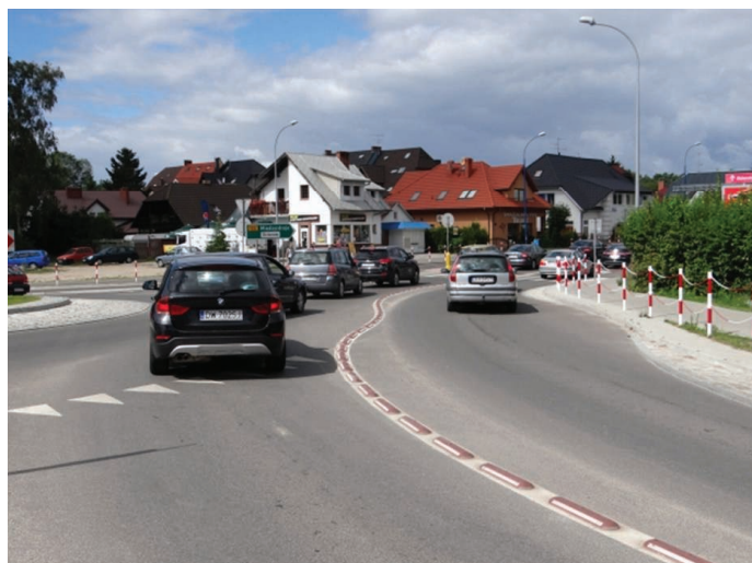
2. Przykład ronda w Dziwnówku – typu „Partiële turborotonde” z dwoma pasami ruchu na wschodniej części jezdni ronda (Fot. A. Sołowczuk)
