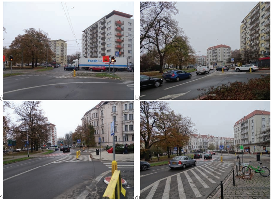
11. Ośmiowłotowy pl. Grunwaldzki z dostępem pieszych na wyspę środkową (Fot. Alicja Sołowczuk) a) wydłużenie pasa dzielącego na wlocie dwujezdniowym z dwutorową linią tramwajową b) wydłużenie wyspy dzielącej na wlocie ulicy dwupasowej dwukierunkowej c) przeznaczenie pasa zewnętrznego na jezdni ronda tylko na relację skrzyżowania w prawo d) skrócenie przejścia dla pieszych tylko do dwóch pasów ruchu
