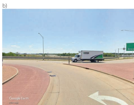
3. Rondo typu „look-a-like” na skrzyżowaniu drogi stanowej 41 z ulicami Breezewood Ln oraz W Bell St Neenah w USA: a) plan czterech rond; b) mulda i dostosowane wpusty deszczowe do jej obłego kształtu; c) widok na krawężnik oddzielający przejezdną część ronda od jezdni ronda (Źródło: Google Earth [18] – współrzędne geograficzne 44°9'22.55"N, 88°29'8.49"W)
