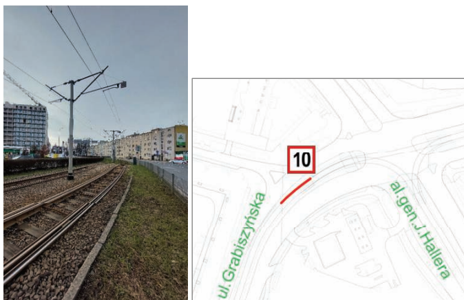
15. Ul. Grabiszyńska, widok od strony FAT. Ograniczenie do 10km/h wprowadzone z powodu braku geometrii zwrótnicy zjazdowej, obowiązują wyłącznie na torze w kierunku ul. Fiołkowej
