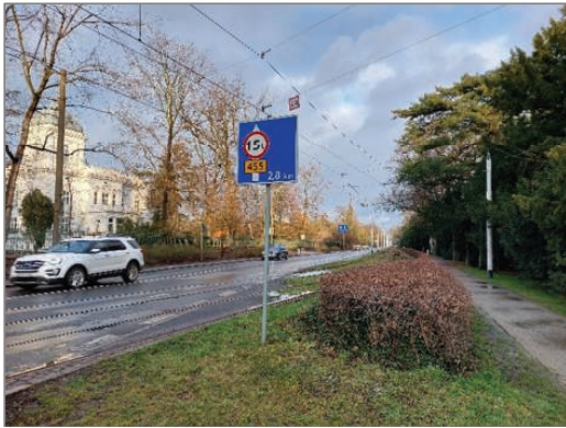
11. Ul. Mickiewicza, widok od ul. Wystawowej. Ograniczenie do 20km/h obowiązujące na długości od ul. Wystawowej do ul. Paderewskiego. Z uwagi na stan tor jest wyłączony z eksploatacji i wykorzystywany wyłącznie do jazdy awaryjnej lub na potrzeby objazdów. Dodatkowo na długości skrzyżowania z ul. Kopernika obowiązuje ograniczenie do 10km/h
