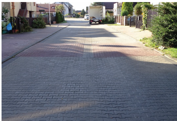
14. Zastosowane progi zwalniające płytowe
