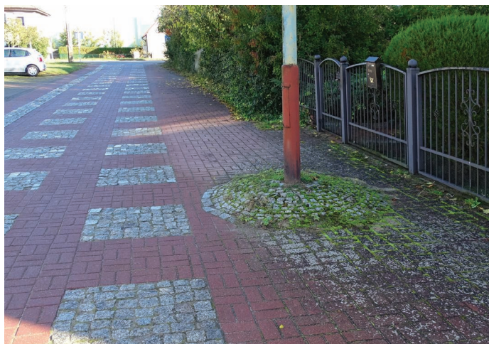
16. Wniesiona nawierzchnia wokół latarni ulicznej
