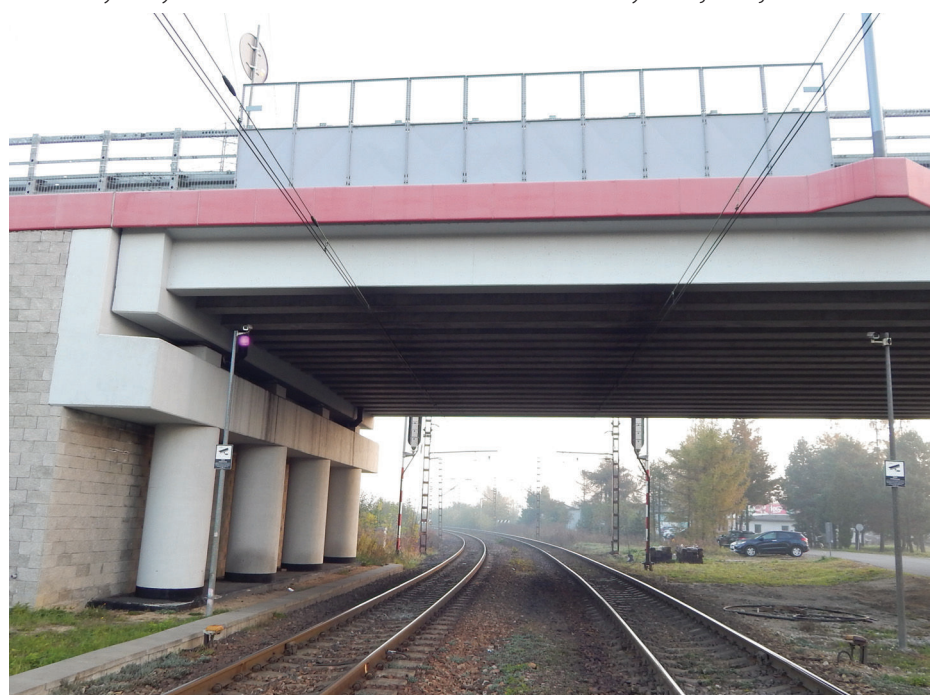
1. Należycie utrzymywany wiadukt drogowy z widocznym torowiskiem linii kolejowej
