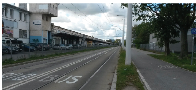
6. Torowisko „niezależne” - poprowadzone w oddaleniu od ulic Braniborskiej i Robotniczej (pomiędzy nimi) wraz ze ścieżką rowerową i chodnikiem
