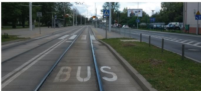
7. Torowisko „z boku” ul. Strzegomskiej (przy skrzyżowaniu z ul. Nowosolską)
