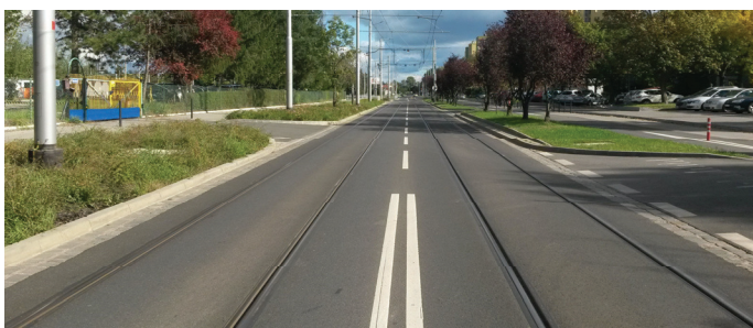
9. Torowisko „w dwupasowej jezdni” w zakończeniu TAT na ul. Rogowskiej
