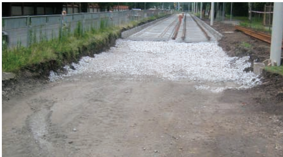
5. Rozwiązanie typu „kanapka” z niesortem jako warstwą szczelną i drenażem w międzytorzu, pod klasyczne tory niezabudowane (ul. Grabiszyńska 2015)
