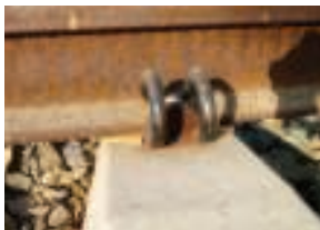
Na okładce: Mocowanie szyny" (fot. P. Mackiewicz)
