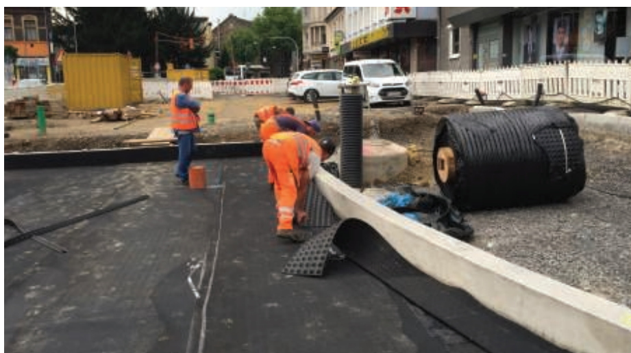
4. Widok ogólny montażu systemu masowo – sprężystego: etap rozkładania pionowych mat wibroizolacyjnych oraz profili łączących. fot. Calenberg Ingenieure
