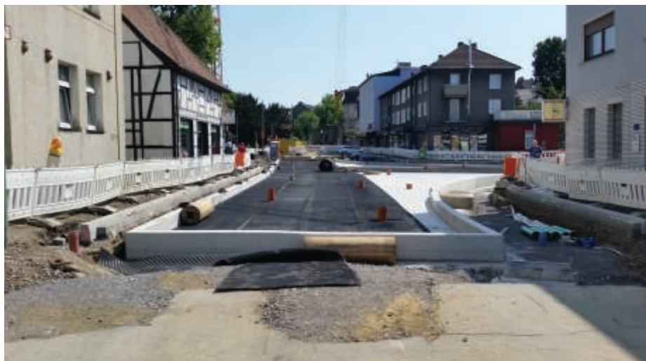
3. Widok ogólny montażu systemu masowo – sprężystego: etap rozkładania poziomych mat wibroizolacyjnych na przygotowanym podłożu. fot. Calenberg Ingenieure
