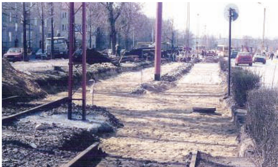
1. Rozwiązanie typu „tylko piasek”, pod klasyczne tory niezabudowane (Al. Hallera, 1997)
