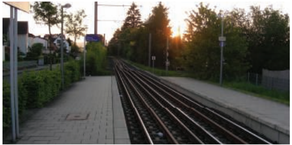
2. Splot torowy na przystanku Niederkaufungen Mitte na trasie tramwajowej linii 4 z Kassel do Hessisch Lichtenau (fot. Igor Gisterek)
