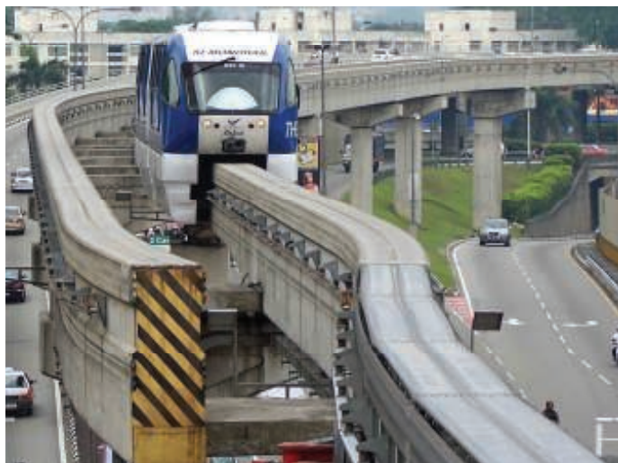
1. Kolej jednoszynowa w Kuala Lumpur [15]
