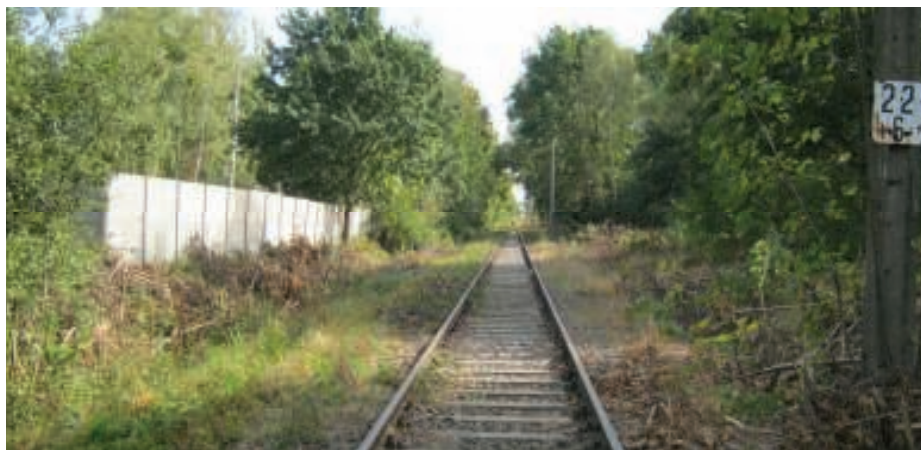
1. Linia kolejowa nr 292 na odcinku pomiędzy stacjami Wr. Sołtysowice i Wr. Osobowice
