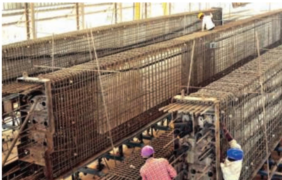
3. Przygotowanie zbrojenia [9]
