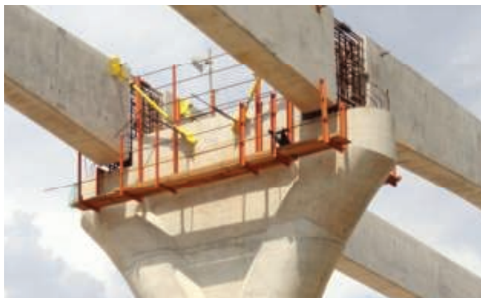
9. Stabilizacja dźwigarów po montażu na podporze [14]
