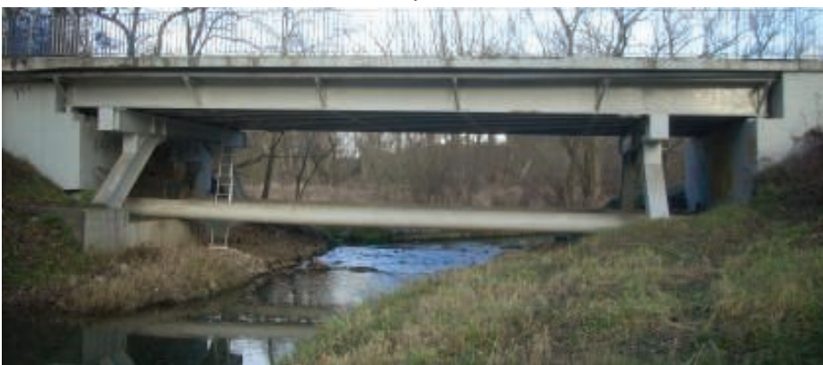
3. Widok ogólny mostu po wzmocnieniu
