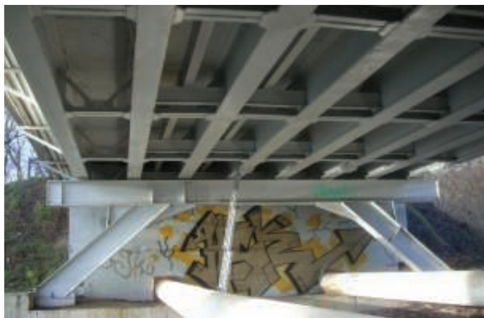
4. Konstrukcja mostu w widoku od spodu przęsła po wzmocnieniu
