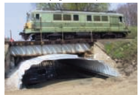
1. Przebudowa obiekt belkowego na gruntowo-powłokowy
