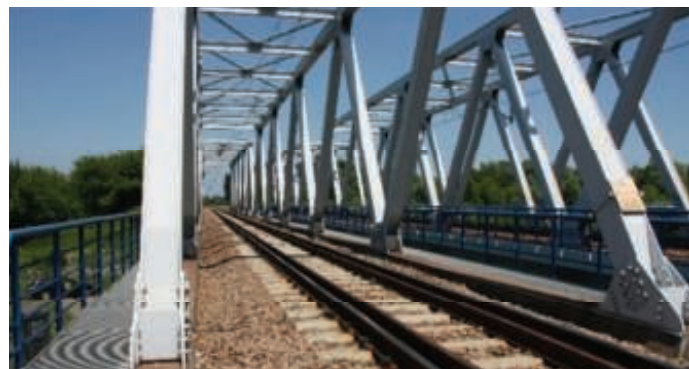
4. Most kratownicowy z pomostem stalowym i torem ułożonym na podsypce
