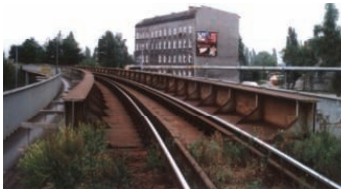
1. Wiadukt blachownicowy z pomostem stalowym bez podsypki
