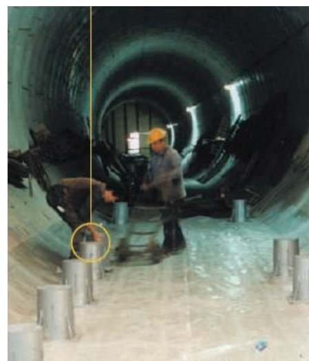
6. Kalibracja napięcia sprężyny w tłumiku typu GSI
