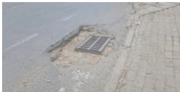
2. Odsłonięte studzienki kanalizacyjne i ubytki asfaltu (Międzyodrzie / Wyspa Pucka). Źródło: opracowanie własne
