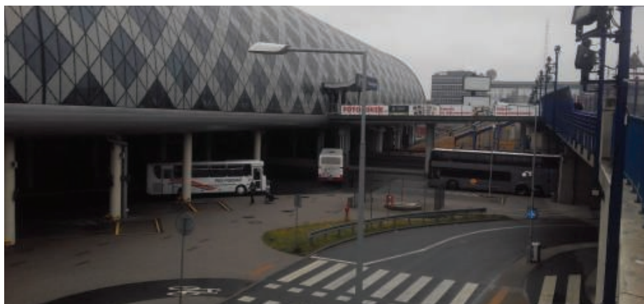
2. Integracja dworca kolejowego z autobusowym w ramach galerii handlowej „Avenida” w Poznaniu.
