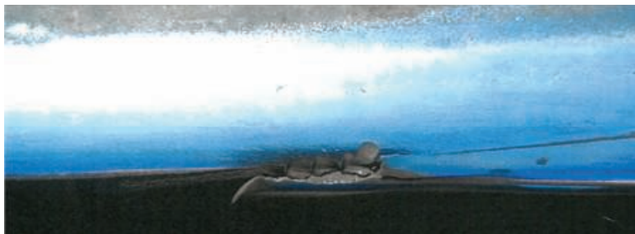
8. Uszkodzony dziób krzyżownicy
