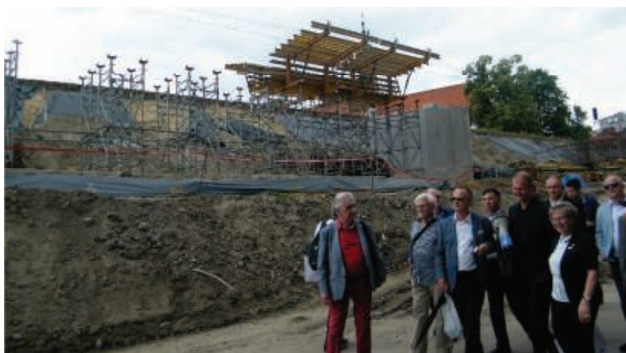
11. Wizytowanie budowy drugiej pary torów na szlaku Kraków Główny – Kraków Płaszów przez uczestników przejazdu pociągu „Ernest Malinowski” w dniu 15 czerwca 2018 r.
