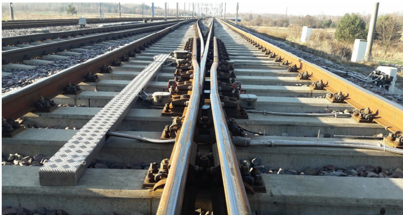
1. Krzyżownica z ruchomym dziobem produkcji TrackTec KolTram. Rozjazd nr 30 na stacji Psary. Źródło: Track Tec
