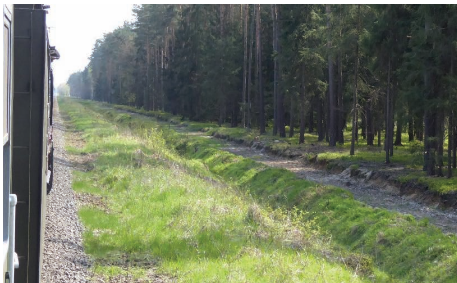
3. Ślad drugiego toru linii kolejowej nr 279 Węglińiec - Lubień Śląski
