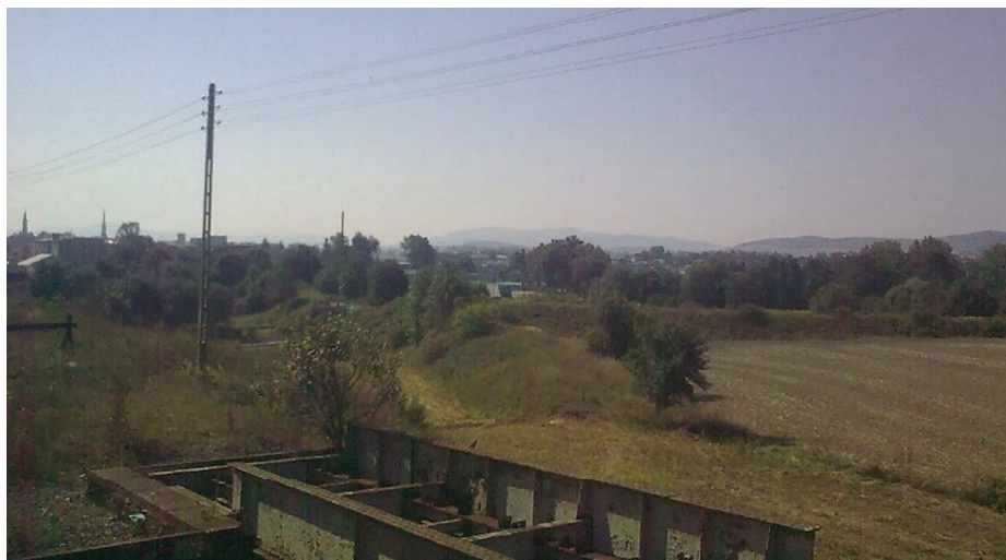
8. Rozwidlenie linii kolejowych 320 i 318 na wyjeździe z Dworca Małego w Zabkowicach Śląskich widziane z nad wiaduktu na linii 137 nad linią 320 w kierunku południowym
