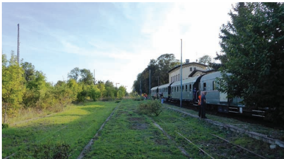
11. Widok na peron 3 stacji Kobierzycze pomiędzy torami 2 i 4, pociąg stoi na torze nr 1
