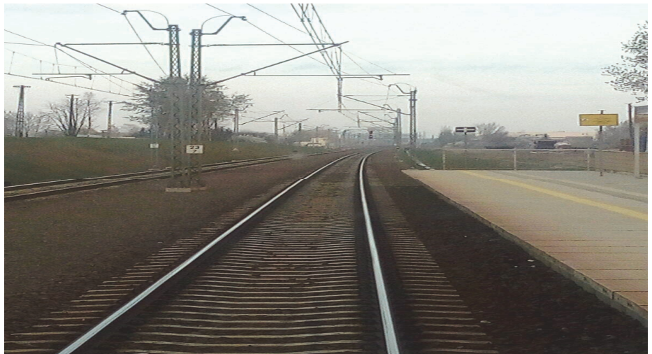
3. Konstrukcje wsporcze zasłaniające widok maszyniście na szlaku
