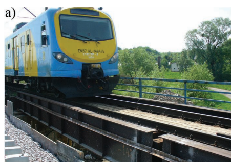
4. Most nad rzeką Radunią w Gdańsku: (a) przęsło skrajne podczas badań eksploatacyjnych, (b) wizualizacja modelu numerycznego przęsła (SOFISTIK)
