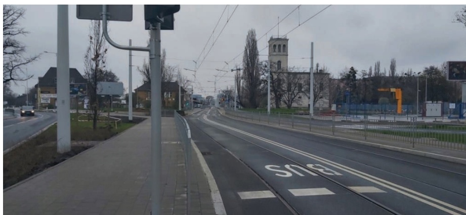
7. Widok z przebudowanego obszaru z rys. 5 w kierunku przeciwnym do rys. 6 (kierunek zachodni) [zdjęcie własne]
