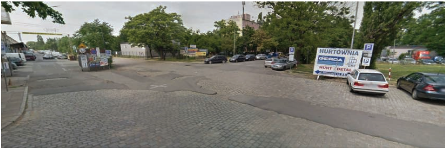
9. Widok na skrzyżowanie ul. Nabycińskiej - ul. Robotniczej przed przebudową [2]
