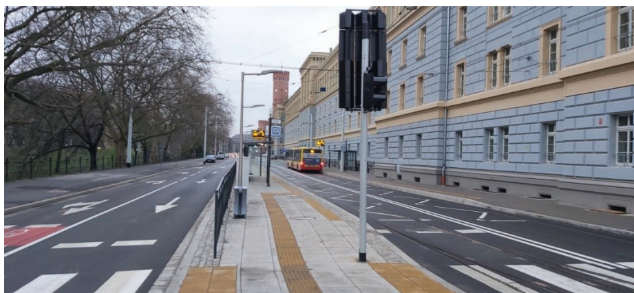
8. Widok na wschodni wlot ul. Podwale po przebudowie [zdjęcie własne]
