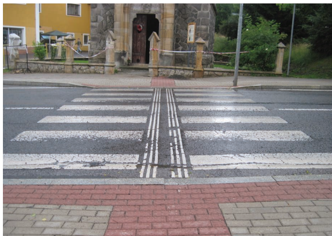
11. Pas prowadzący z mas chemoutwardzalnych w strukturze „zebry”, Harrahov / Czechy (fot. K. Kaperczak)
