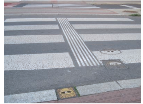
16. Zmodyfikowane pasy prowadzące (pasy nowsze) ze zmniejszoną długością (tylko do pasów podłużnych), Rondo Księstwa Cieszyńskiego, Cieszyn / Polska (fot. K. Kaperczak)
