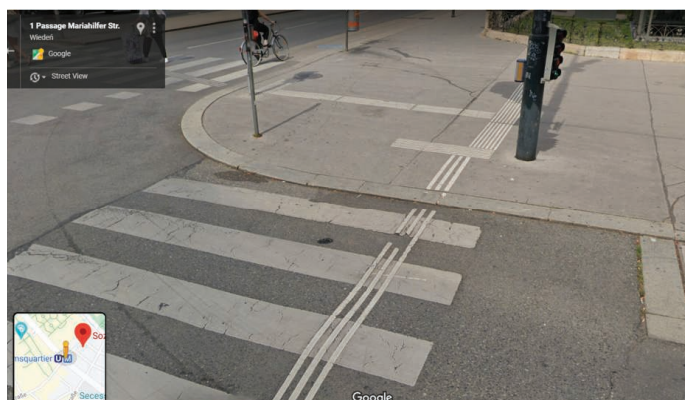
6. Pas prowadzący z mas chemoutwardzalnych - zbliżenie, Wiedeń / Austria (fot. google)
