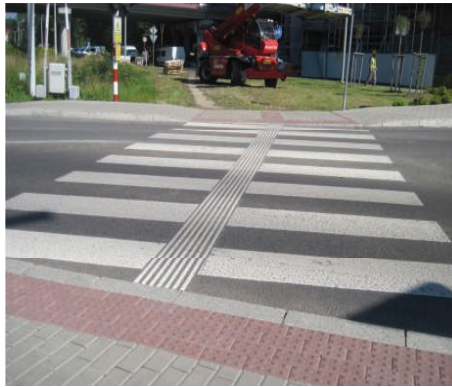
15. Zmodyfikowane pasy prowadzące (pasy starsze) z długością do krawężników, Rondo Księstwa Cieszyńskiego, Cieszyn (Polska) (fot. K. Kaperczak)
