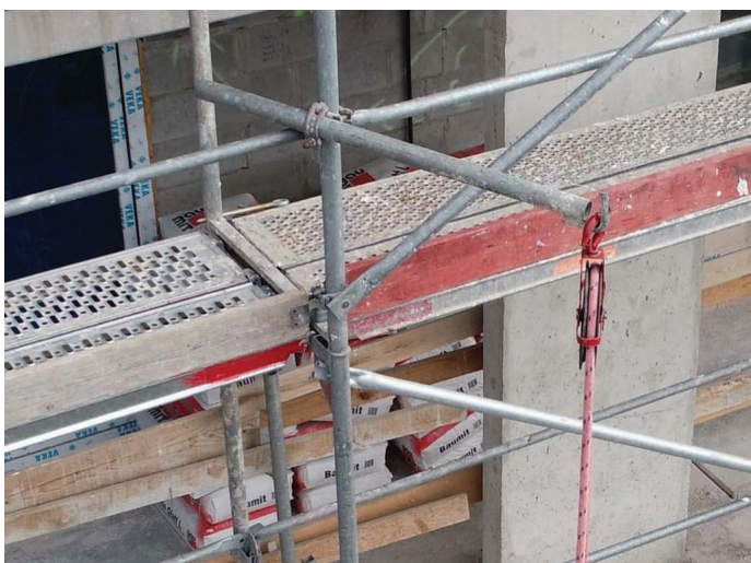
3. Widok na wciągarkę
