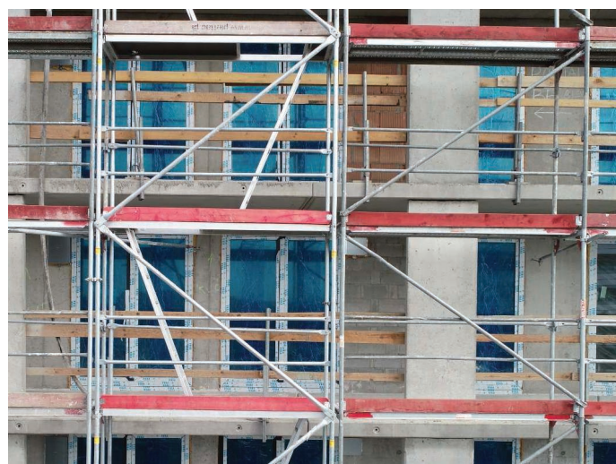
2. Widok na pion stępujący rusztowanie
