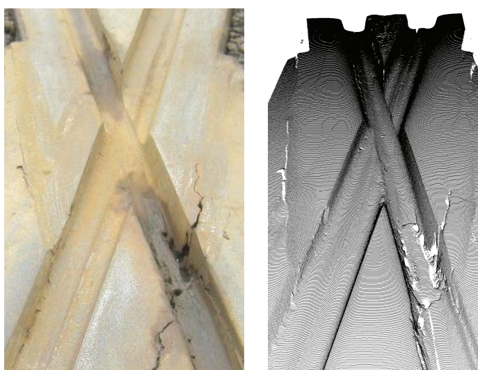
8. Widok rzeczywisty (z lewej) i cyfrowy bliźniak (z prawej) krzyżownicy tramwajowej [11]
