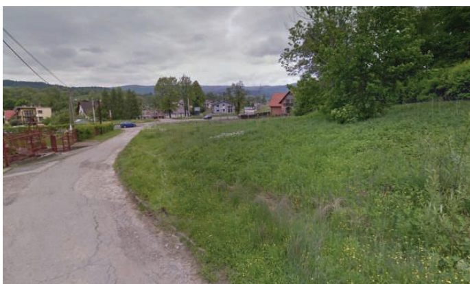
23. Rabka Zdrój. Po prawej stronie działka przy ulicy Zakopiańskiej 48 – rejon usytuowania wlotu tunelu; w oddali linia kolejowa nr 104
