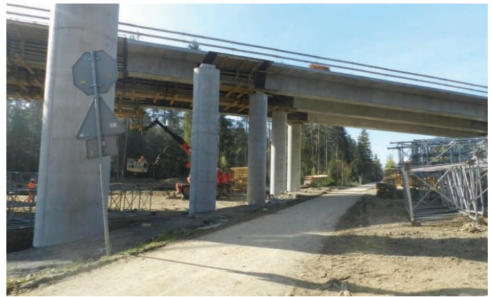
30. ścieżka rowerowa tzw. Velo Dunajec biegnąca po śladzie dawnej linii nr 118 w Nowym Targu pod obiektem WD-121 Obwodnicy Nowego Targu
