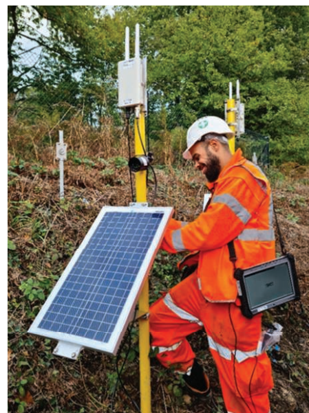
5. Centrala Komunikacyjna EdgeHub, kamera 4G i panel słoneczny
