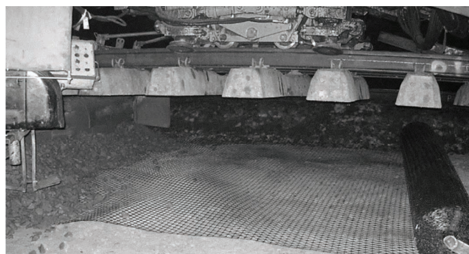
13. Układanie georusztu Tensor TriAx za pomocą maszyny AHM
