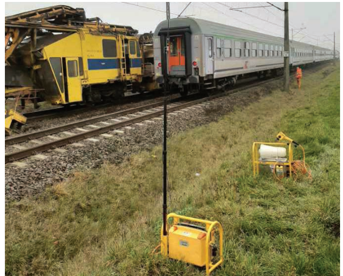
7. ASO podczas pracy z AHM (Zakład Maszyn Torowych Kraków)
