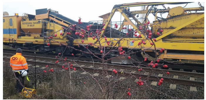
6. ASO podczas pracy z AHM (Zakład Maszyn Torowych Kraków)
