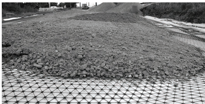
10. Układanie pierwszej warstwy georusztu trójosowego w trakcie modernizacji linii E65 na obszarze LCS Gdańsk
