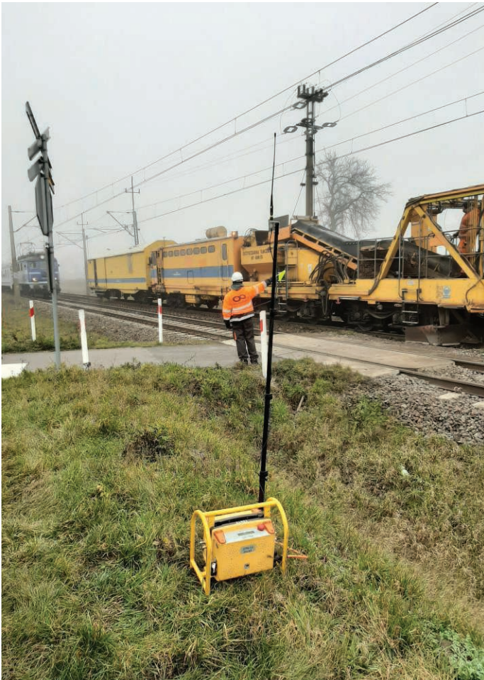
5. ASO podczas pracy z AHM (Zakład Maszyn Torowych Kraków)
