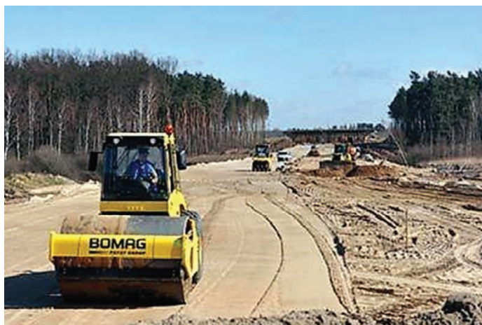
4. Zagęszczanie mechaniczne podłoża gruntowego
