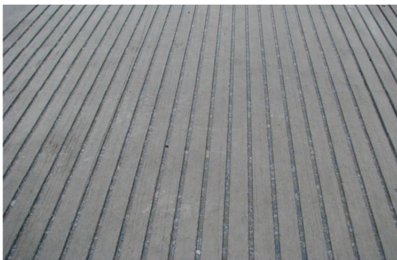
9. Tekstura nawierzchni w wyniku jej rowkowania
