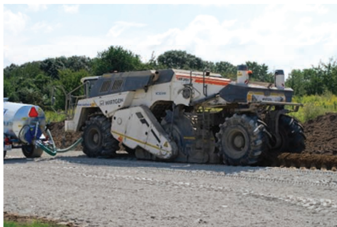
5. Proces mieszania gruntu rodzimego ze środkiem chemicznym
