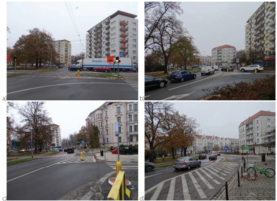
11. Ośmiowłotowy pl. Grunwaldzki z dostępem pieszych na wyspę środkową (Fot. Alicja Sołowczuk) a) wydłużenie pasa dzielącego na wlocie dwujezdniowym z dwutorową linią tramwajową b) wydłużenie wyspy dzielącej na wlocie ulicy dwupasowej dwukierunkowej c) przeznaczenie pasa zewnętrznego na jezdni ronda tylko na relację skrótu w prawo d) skrócenie przejścia dla pieszych tylko do dwóch pasów ruchu
