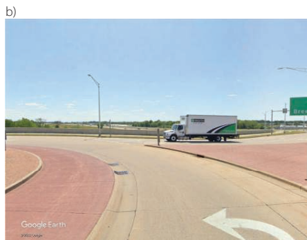
3. Rondo typu „look-a-like” na skrzyżowaniu drogi stanowej 41 z ulicami Breezewood Ln oraz W Bell St Neenah w USA: a) plan czterech rond; b) mulda i dostosowane wpusty deszczowe do jej obłego kształtu; c) widok na krawężnik oddzielający przejezdny część rondo od jezdni rondo (Źródło: Google Earth [18] – współrzędne geograficzne 44°9'22.55"N, 88°29'8.49"W)
