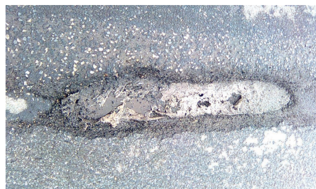
3. Wyboje/ubytki/dziury – przykłady rozległych, powierzchniowych uszkodzeń warstwy ścieralnej z betonu asfaltowego: warstwa ścieralna oddzielona tkaniną od warstwy wiążącej: a) uszkodzenie wgłębne w kształcie eliptyczno-kołowym ze znaczną ilością roztworu, b) uszkodzenie wgłębne w kształcie kołowym z roztworem w warstwie wiążącej, c) uszkodzenie wgłębne nawierzchni w kształcie eliptyczno-podłużnym z widocznym fragmentem soczewki lodowej (z lewej) – uwidoczniona erozja wgłębna warstwy wiążącej pod uszkodzoną warstwą tekstylną
