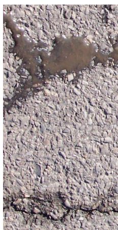
2. Pęknięcia siatkowe, blokowe i liniowe – uszkodzenie nawierzchni asfaltowej polegające na jej spękanii wskutek wytworzenia się wysadzin pod nawierzchnią: widoczne wykroplenie roztworu z lodu zalegającego w podbudowie; roztwór z rozpuszczonego lodu zalegającego w podbudowie wydostaje się na górną powierzchnię nagrzanej od promieniowania słonecznego nawierzchni pod wpływem grawitacji i obciążenia zewnętrznego
