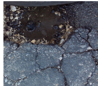
4. Wyboje: a) Fragment nawierzchni drogowej ze znacznymi ubytkami w warstwie ścieralnej z betonu asfaltowego, jak również w warstwie wiążącej i w podbudowie; b) koło pojazdu zagłębione we wgłębny ubytek wierzchniej warstwy drogowej sięgającej do podbudowy, z widocznymi zastoinami roztworu
