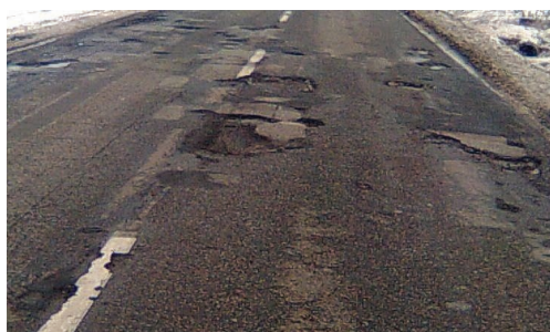
4. Wyboje: a) Fragment nawierzchni drogowej ze znacznymi ubytkami w warstwie ścieralnej z betonu asfaltowego, jak również w warstwie wiążącej i w podbudowie; b) koło pojazdu zagłębione we wgłębny ubytek wierzchniej warstwy drogowej sięgającej do podbudowy, z widocznymi zastoinami roztworu
